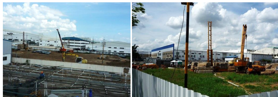
現在、順調に工事は進行しております
